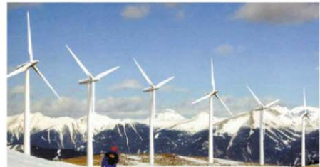
Österreichs derzeit höchstgelegener Windpark bei Oberzeiring (1835 m) in der Steiermark produziert Strom für 8570 Haushalte. Foto: APA
