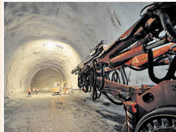
Die Tunnel-Bohrmaschine stößt auf gerichtlichen Granit.
